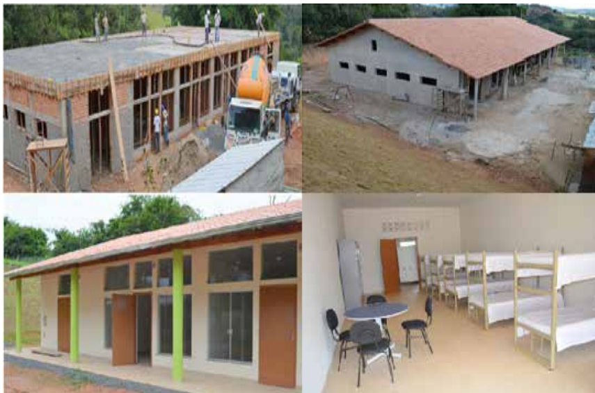
Figura 34 – Novo Alojamento feminino: etapas da construção
