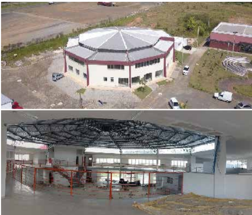
Figura 44 – Obras da nova biblioteca do Campus Poços de Caldas
