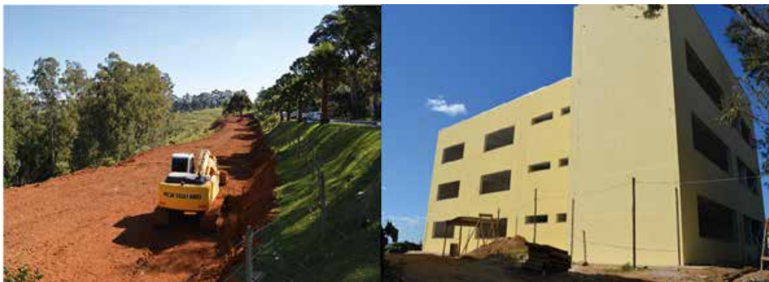
Figura 37 – Obras do Prédio Pedagógico do curso de Medicina Veterinária
