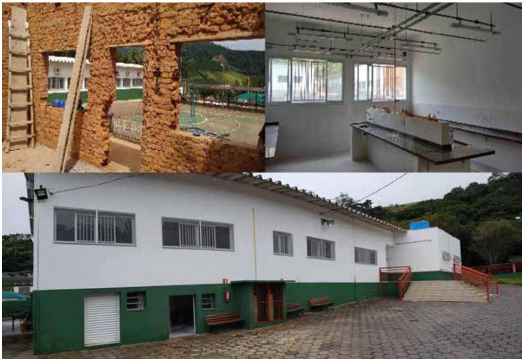
Figura 50 – Laboratório de Alimentos Campus Avançado Carmo de Minas
