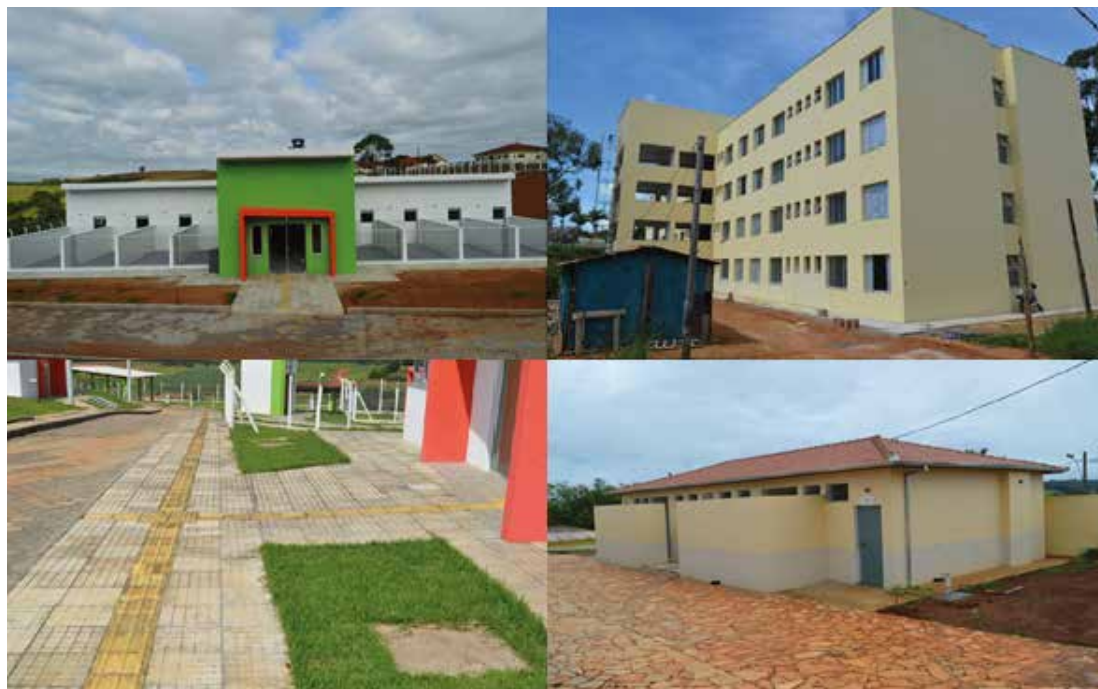
Figura 38 – Algumas das obras no Campus Muzambinho 26
