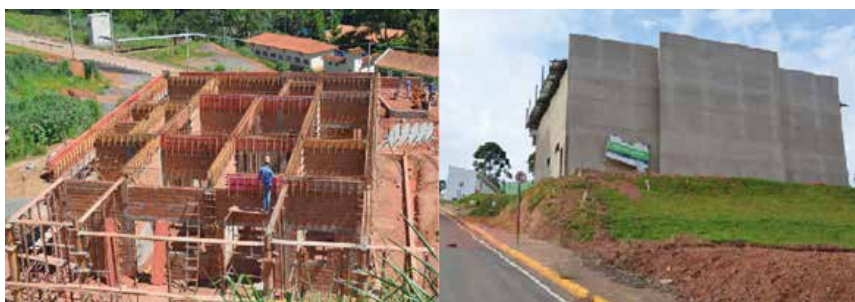
Figura 33 – Novo auditório: em construção e com a obra quase finalizada
