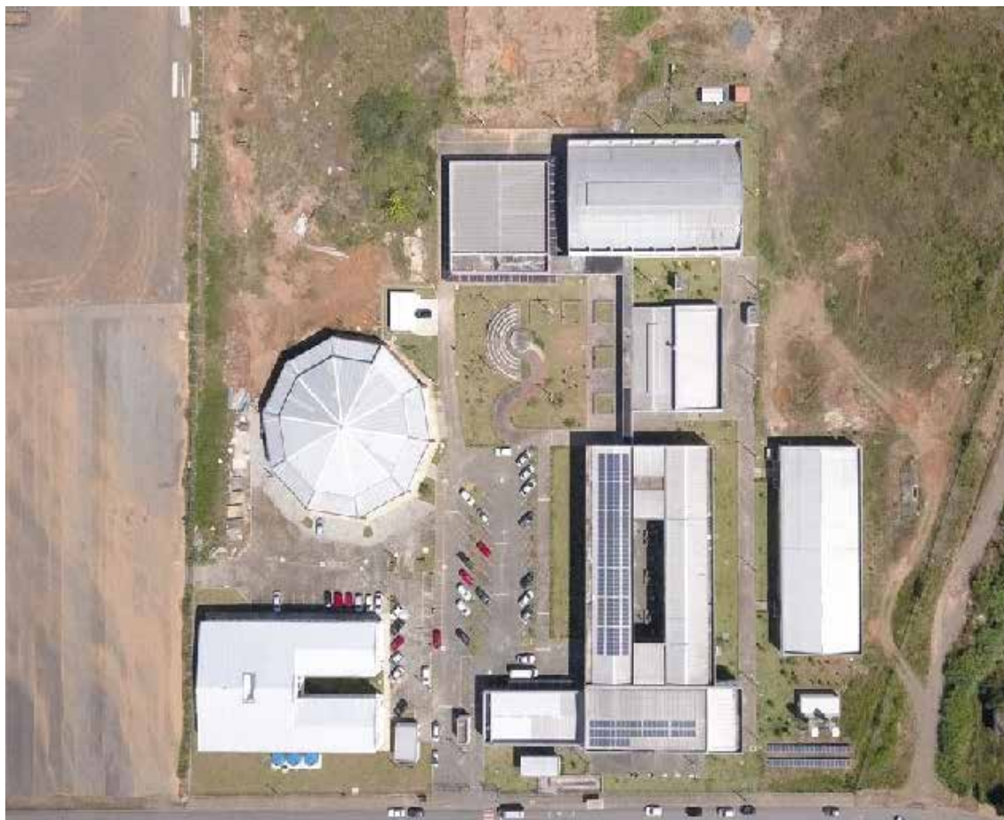
Figura 45 – Campus Poços de Caldas – visão aérea
