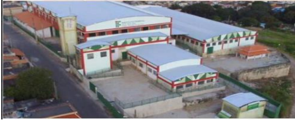
Figura 8 - Novas instalações do Campus Avançado Três Corações - Unidade II
