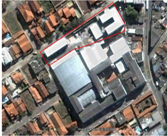
Figura 6 - Vista aérea das instalações do Campus Avançado Três Corações (Unidade I)
