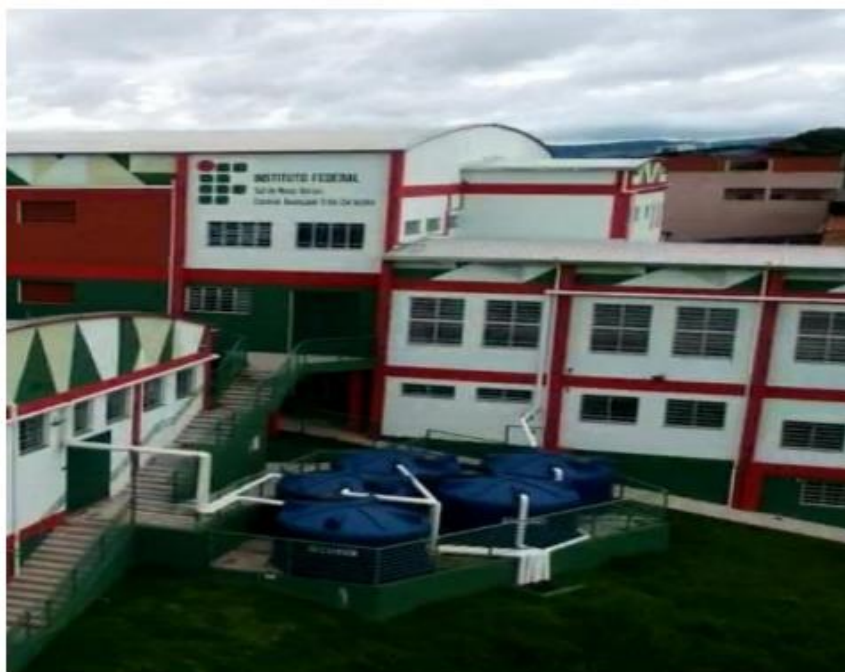
Figura 10 - Estação de coleta de águas pluviais (Unidade II)
