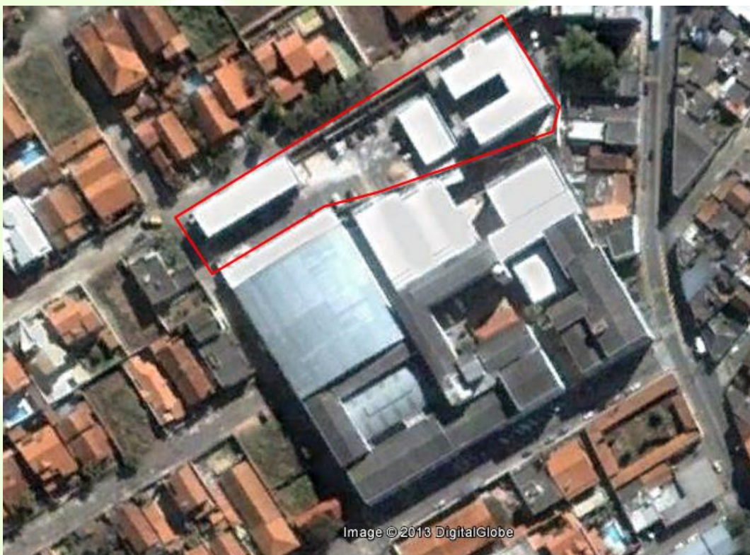
Figura 3: Vista aérea das instalações do Câmpus Avançado de Três Corações
