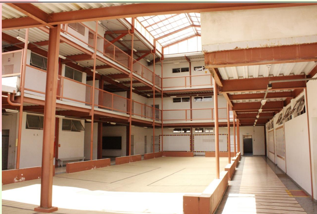
Figura 4: Pavilhão pedagógico (salas de aula)
