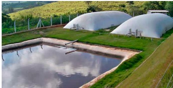
Conjunto de biodigestores tubulares de fluxo contínuo, em laminado de PVC, com capacidade 300 m<sup>3</sup> cada de resíduos e potencial para produzir 19.710 m<sup>3</sup> de biogás por ano que convertido em energia tem potencial de 25.9150 KWh.
