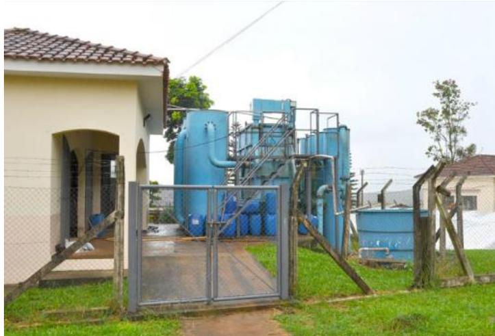
A Estação de Tratamento Água tem uma vazão de 8,0 l/s. A área é dividida em:
