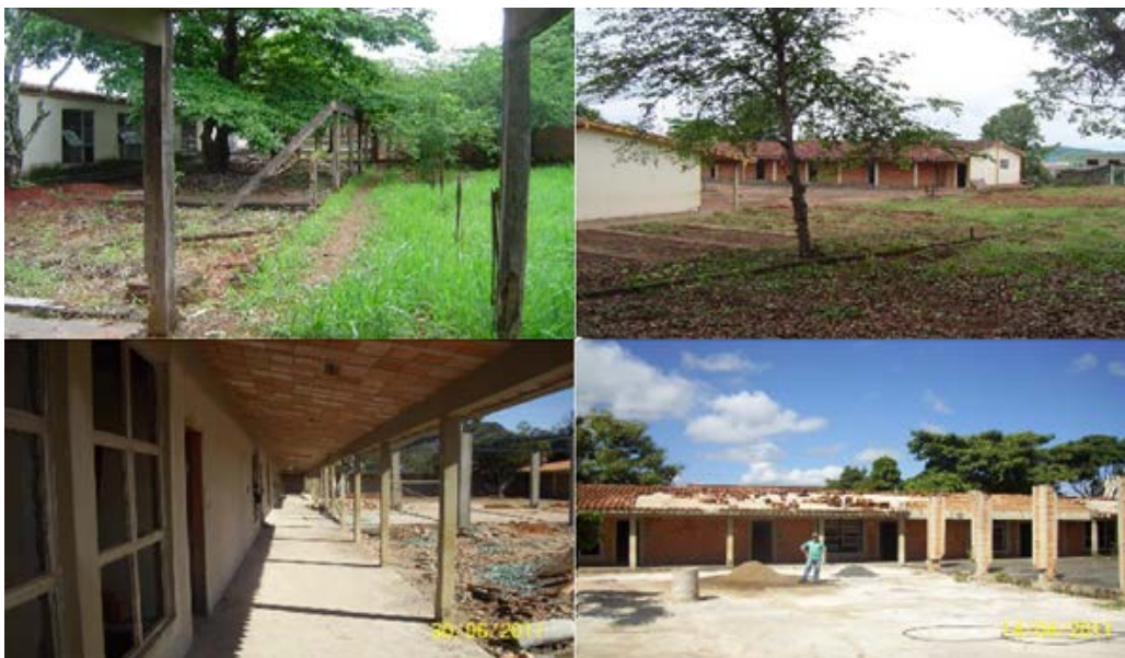
Figura 40 – Campus Passos antes das obras de revitalização do espaço
