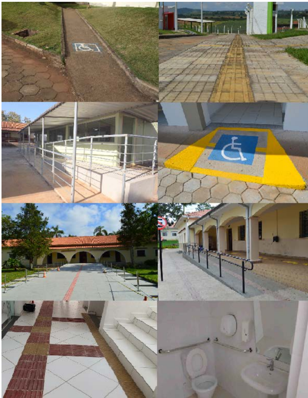
Figura 70 – Obras realizadas para adequação e inclusão de pessoas com deficiência
