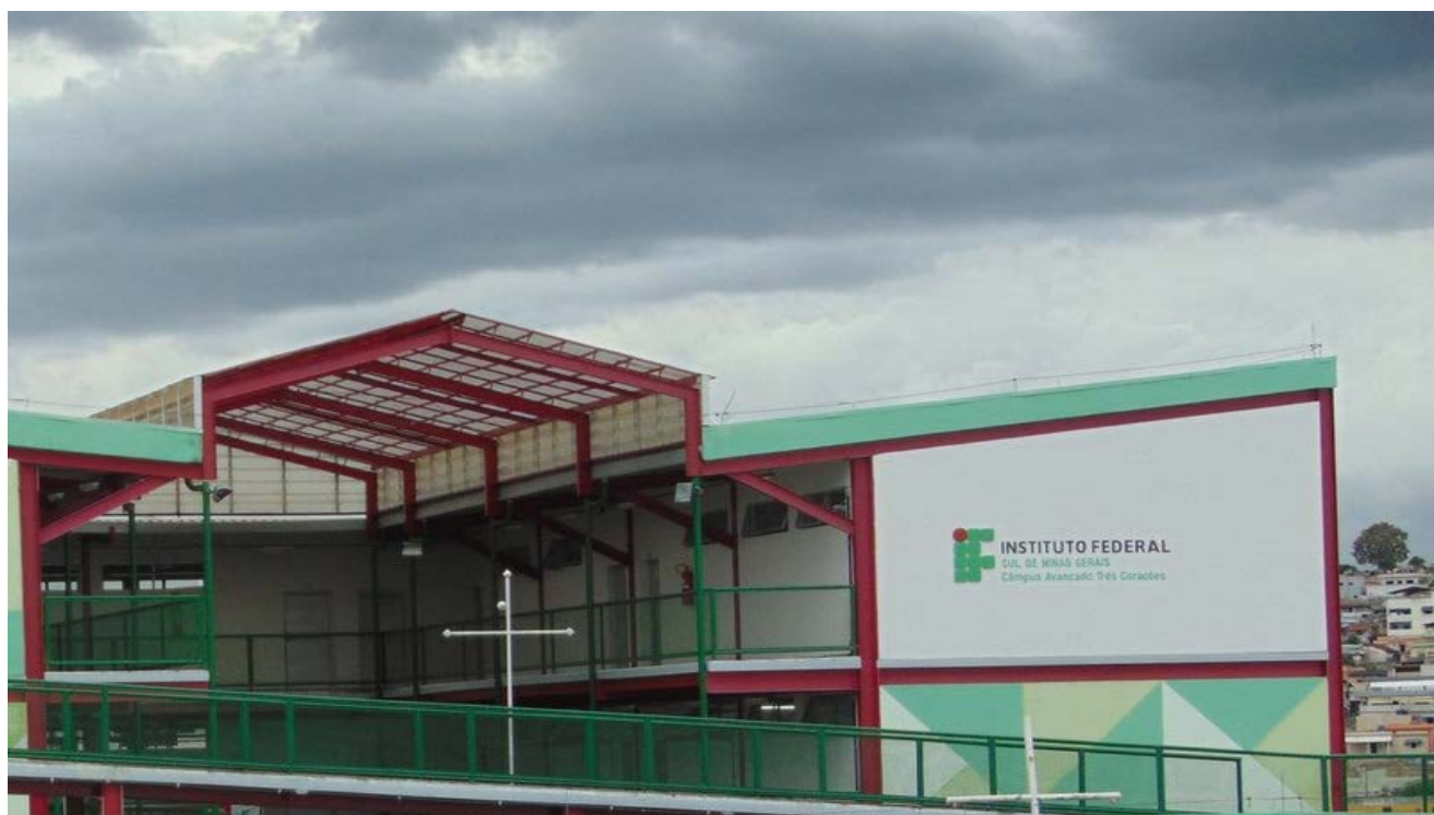
Figura 08 – Fachada do Campus Avançado Três Corações
