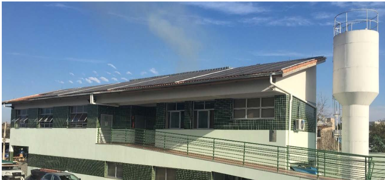
Figura 56 – Vista do prédio da DTIC 28
