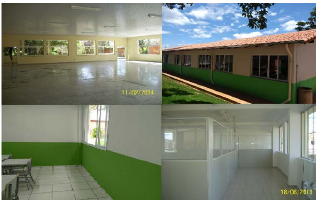
Figura 41 – Obras no Campus Passos
