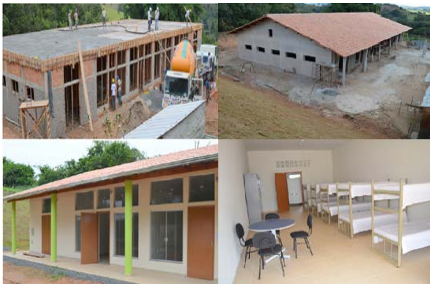
Figura 34 – Novo Alojamento feminino: etapas da construção
