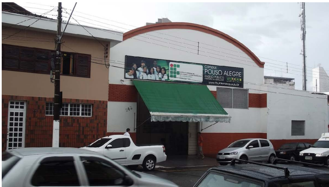
Figura 46 – Fachada da primeira sede do Campus Pouso Alegre
