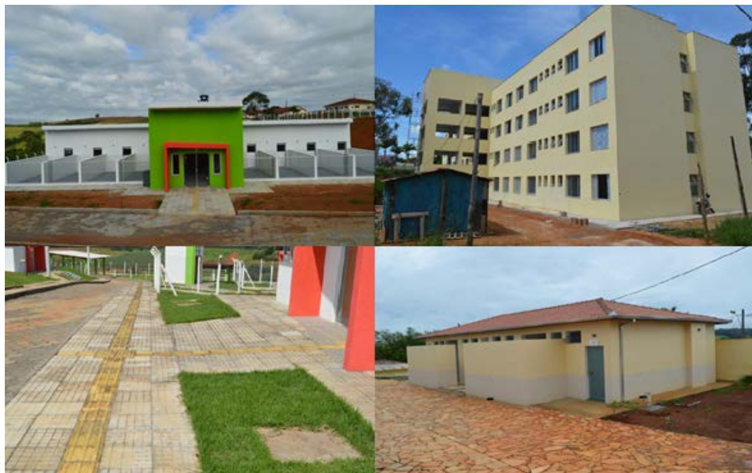
Figura 38 – Algumas das obras no Campus Muzambinho 26
