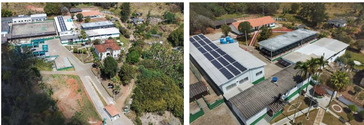
Figura 10 - Vista aérea das instalações do Campus Avançado Carmo de Minas Fonte: Geovanini [arquivo pessoal], 2017.
