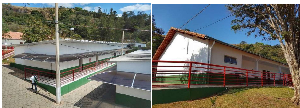
Figura 12 - Salas de Aula Fonte: Geovanini [arquivo pessoal], 2017.
