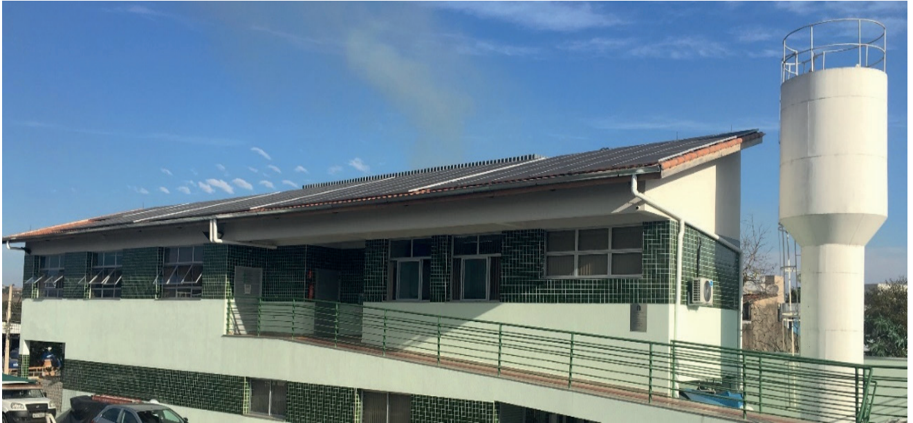
Figura 57 – Vista do prédio da DTI 28
