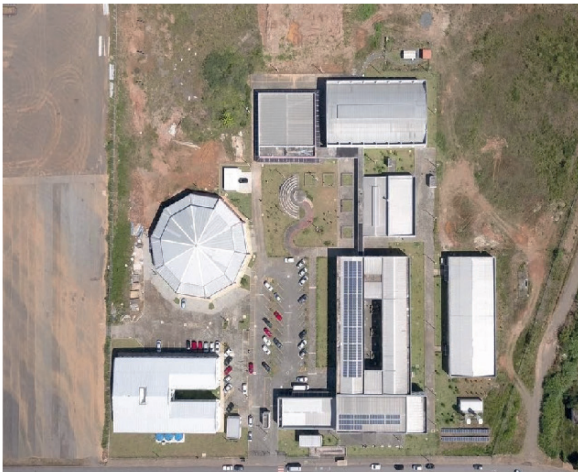
Figura 46 – Campus Poços de Caldas – visão aérea
