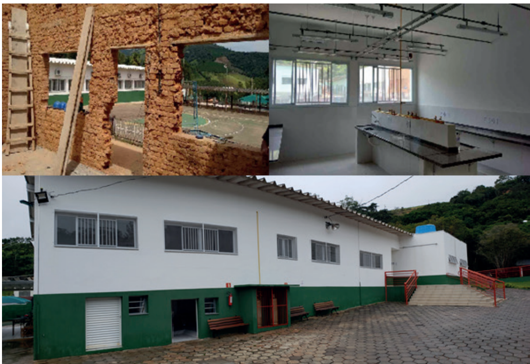
Figura 51 – Laboratório de Alimentos Campus Avançado Carmo de Minas
