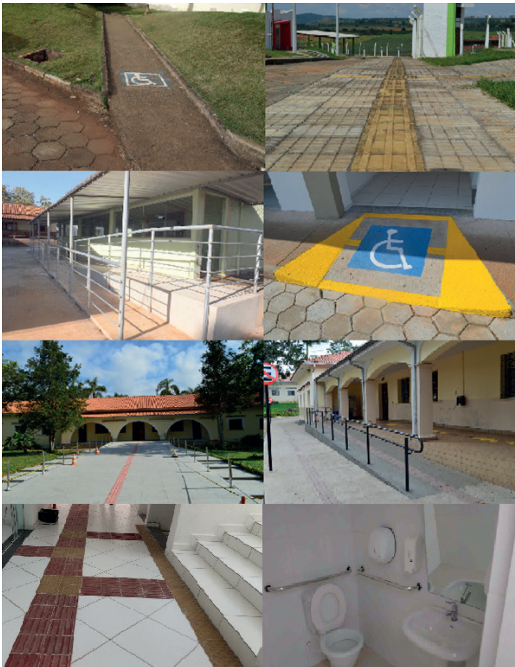
Figura 71 – Obras realizadas para adequação e inclusão de pessoas com deficiência
