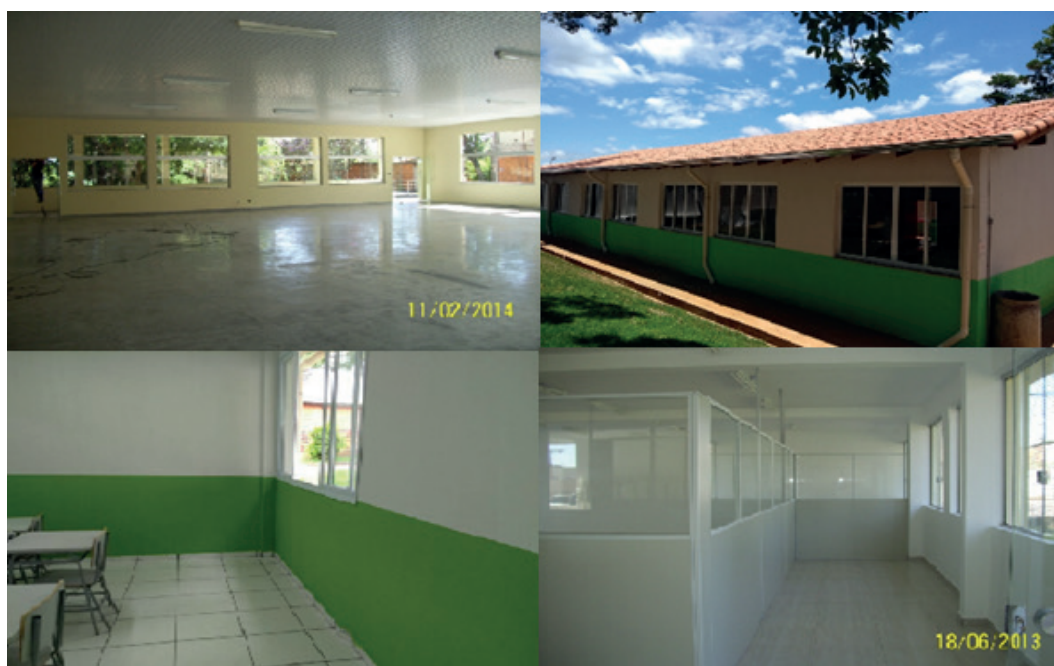
Figura 42 – Obras no Campus Passos
