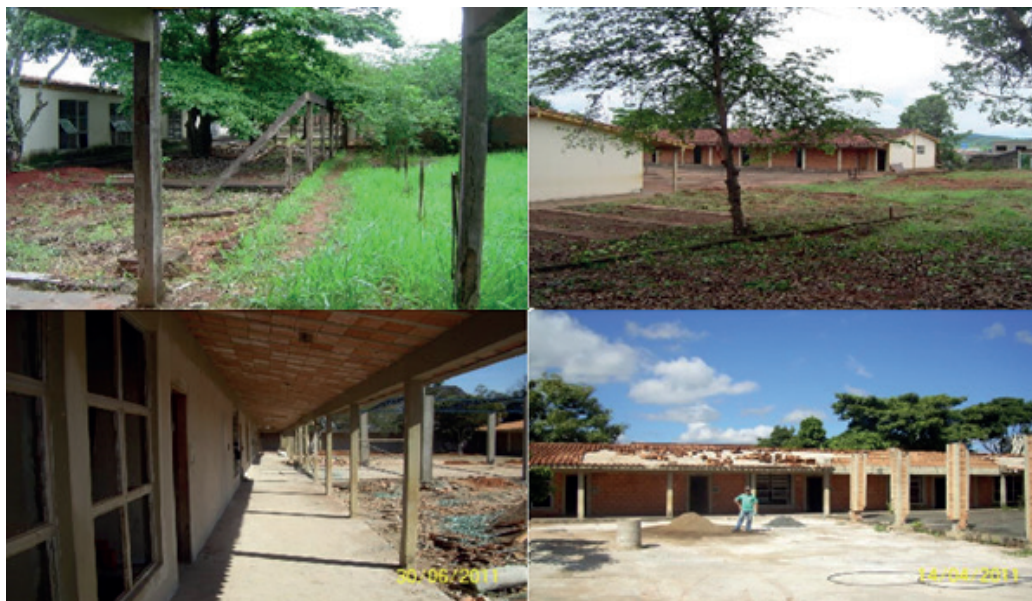
Figura 41 – Campus Passos antes das obras de revitalização do espaço
