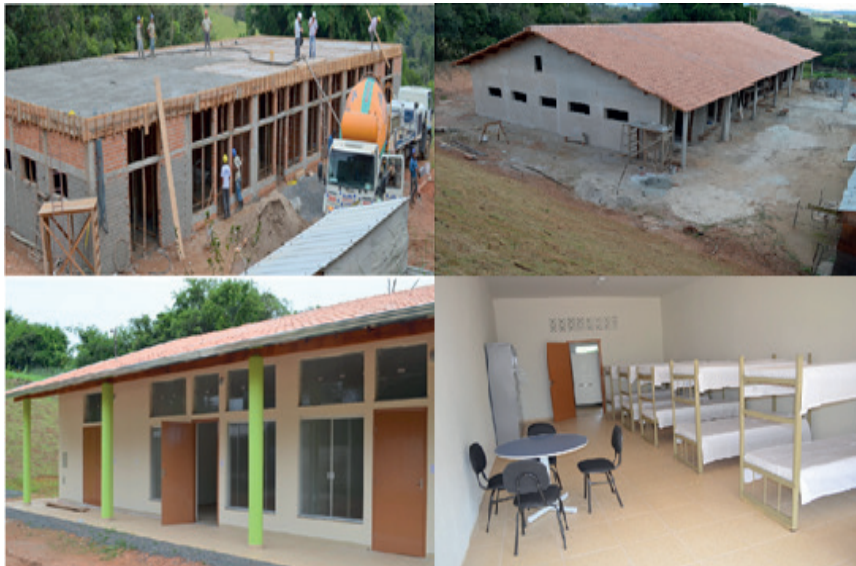
Figura 35 – Novo Alojamento feminino: etapas da construção
