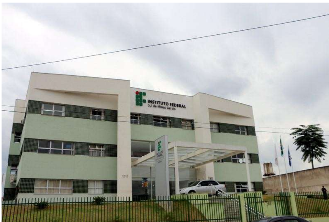
Figura 10 – Fachada do prédio principal da Reitoria do IFSULDEMINAS
