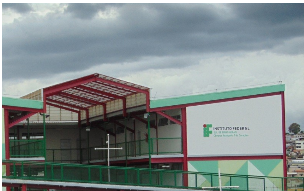
Figura 8 - Fachada do Campus Avançado Três Corações
