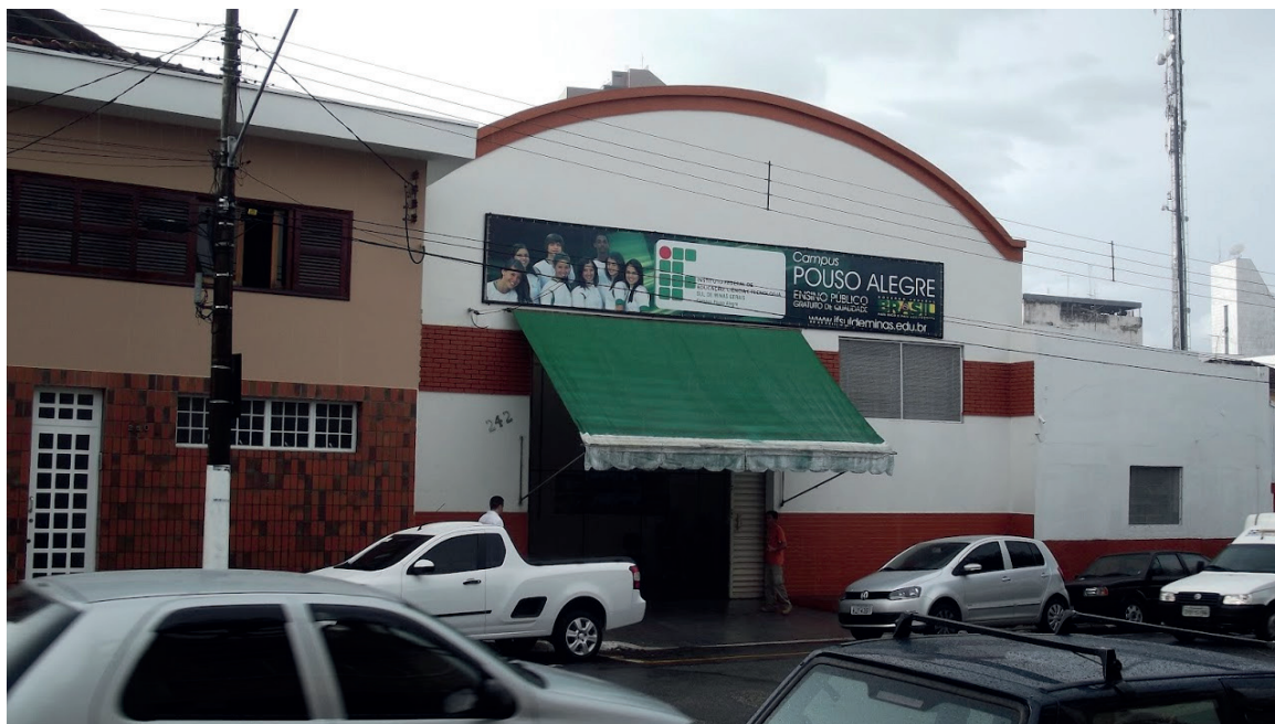
Figura 47 – Fachada da primeira sede do Campus Pouso Alegre
