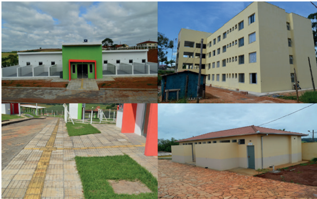
Figura 39 – Algumas das obras no Campus Muzambinho 26
