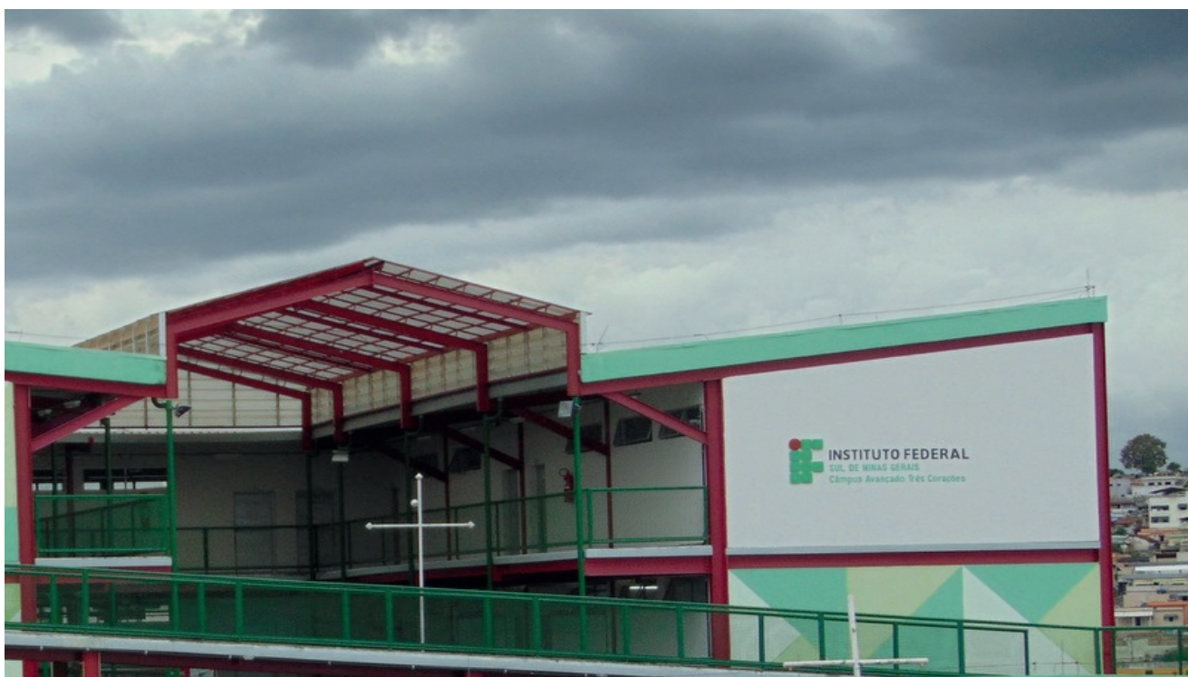
Figura 08 – Fachada do Campus Avançado Três Corações
