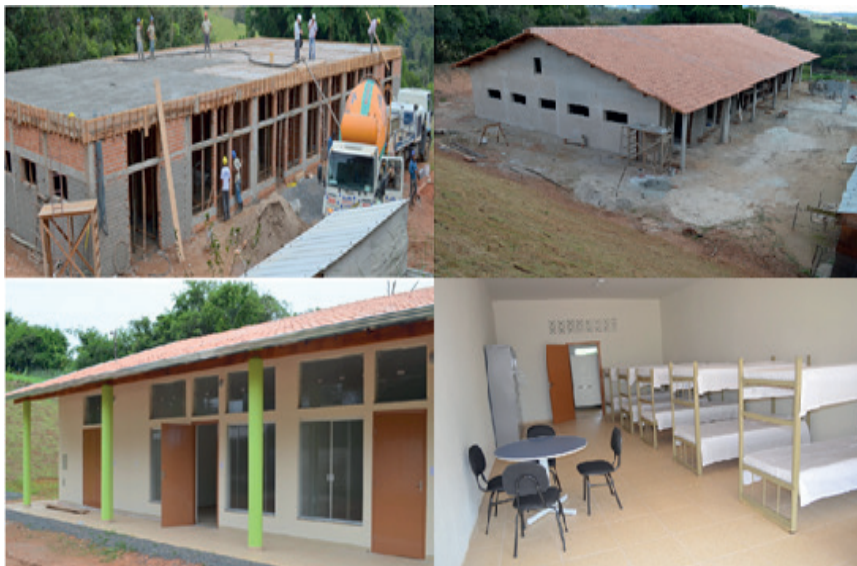
Figura 35 – Novo Alojamento feminino: etapas da construção
