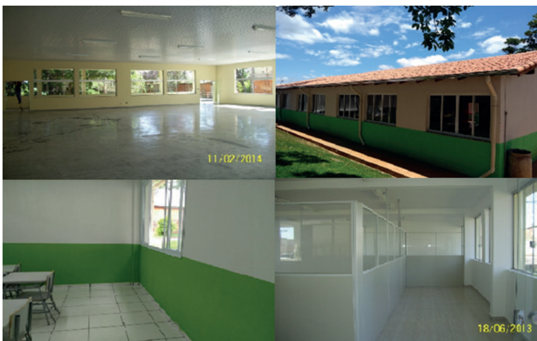
Figura 42 – Obras no Campus Passos
