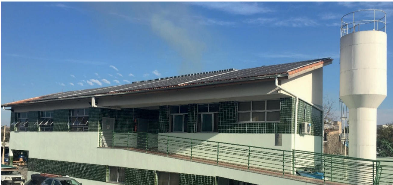
Figura 57 – Vista do prédio da DTI 28
