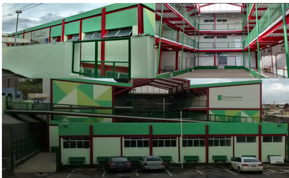
Figura 6 - Blocos pedagógicos e administrativos (Campus I).
