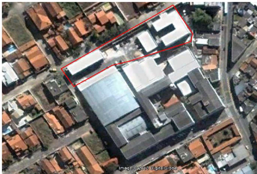
Figura 6 - Vista aérea das instalações do Campus Avançado Três Corações
