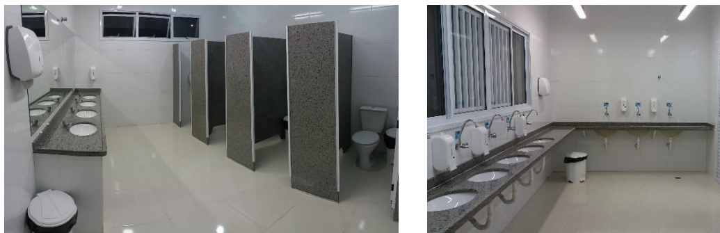
Figura 17 - Sanitários e Barreira Sanitária
