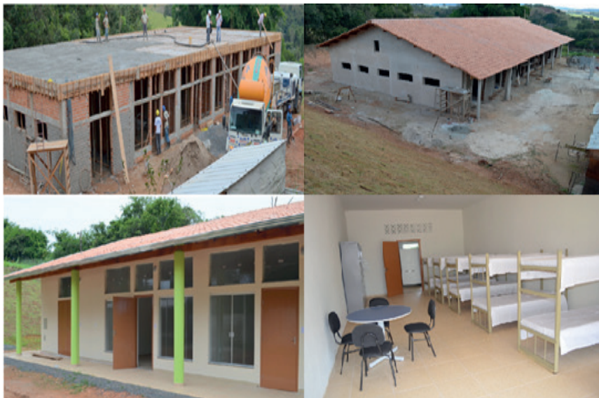
Figura 35 – Novo Alojamento feminino: etapas da construção
