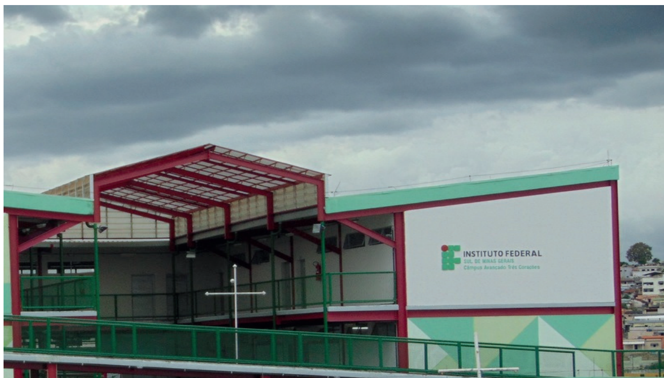
Figura 08 – Fachada do Campus Avançado Três Corações
