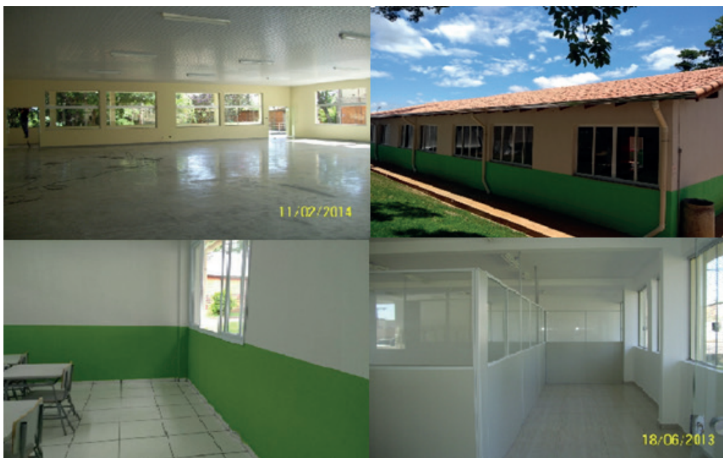
Figura 42 – Obras no Campus Passos
