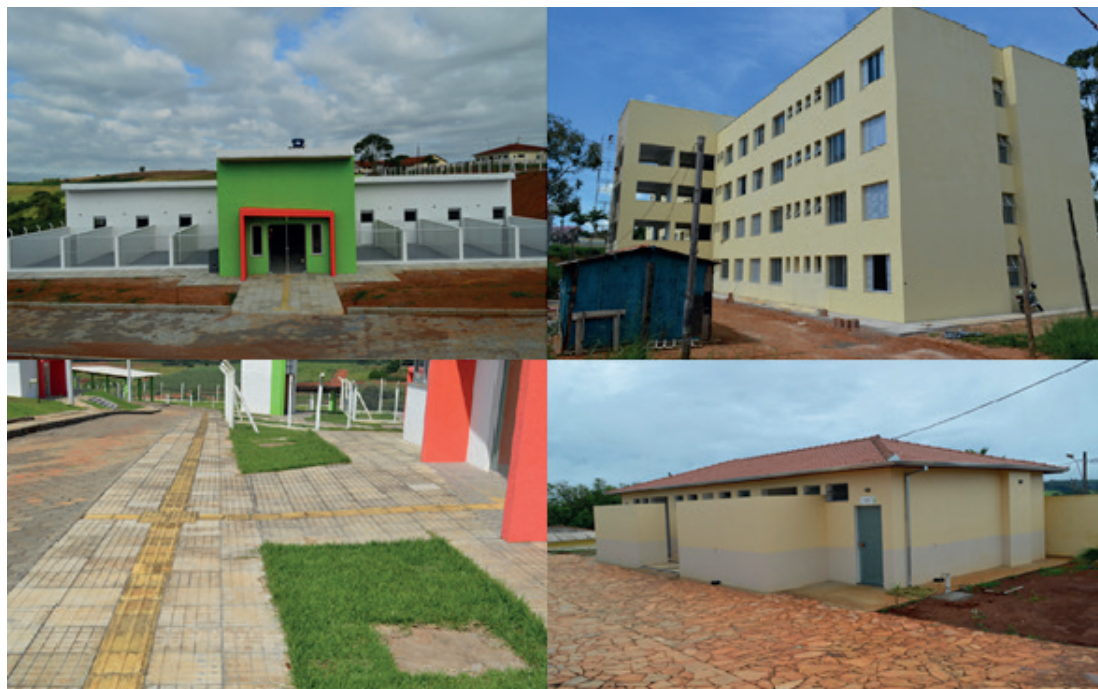
Figura 39 – Algumas das obras no Campus Muzambinho 26
