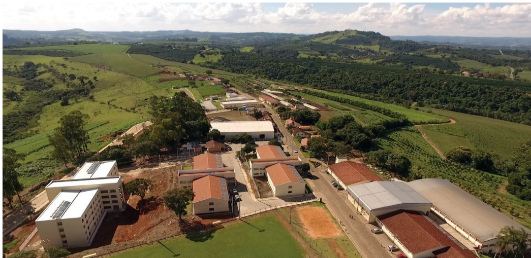
Figura 40 – Vista aérea do Campus Muzambinho
