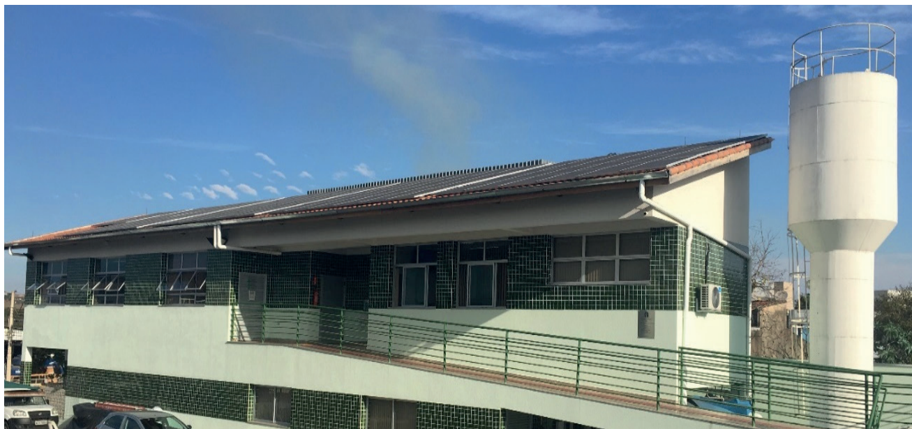
Figura 57 – Vista do prédio da DTI 28
