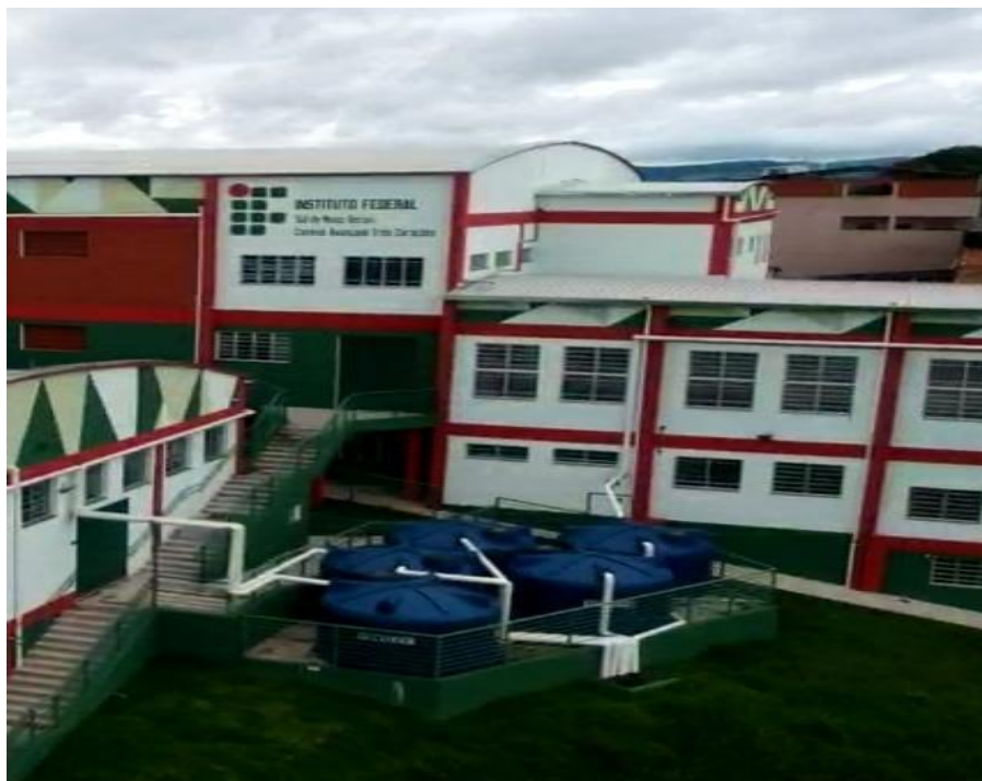
Figura 8 - Novas instalações do Campus Avançado Três Corações (Campus II) - Captação de água
