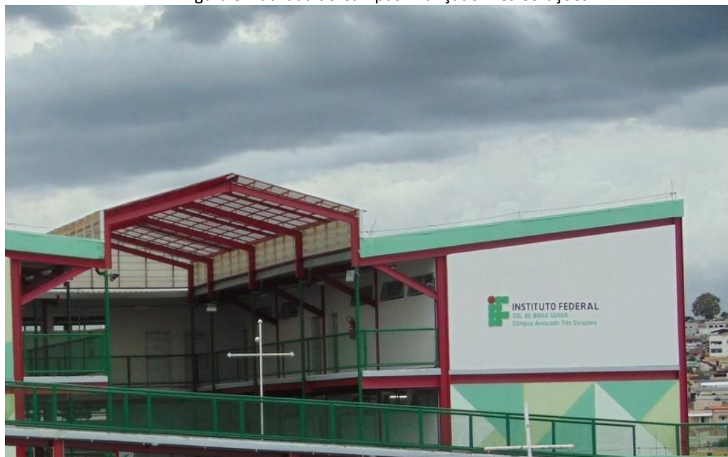
Figura 8: Fachada do Campus Avançado Três Corações
