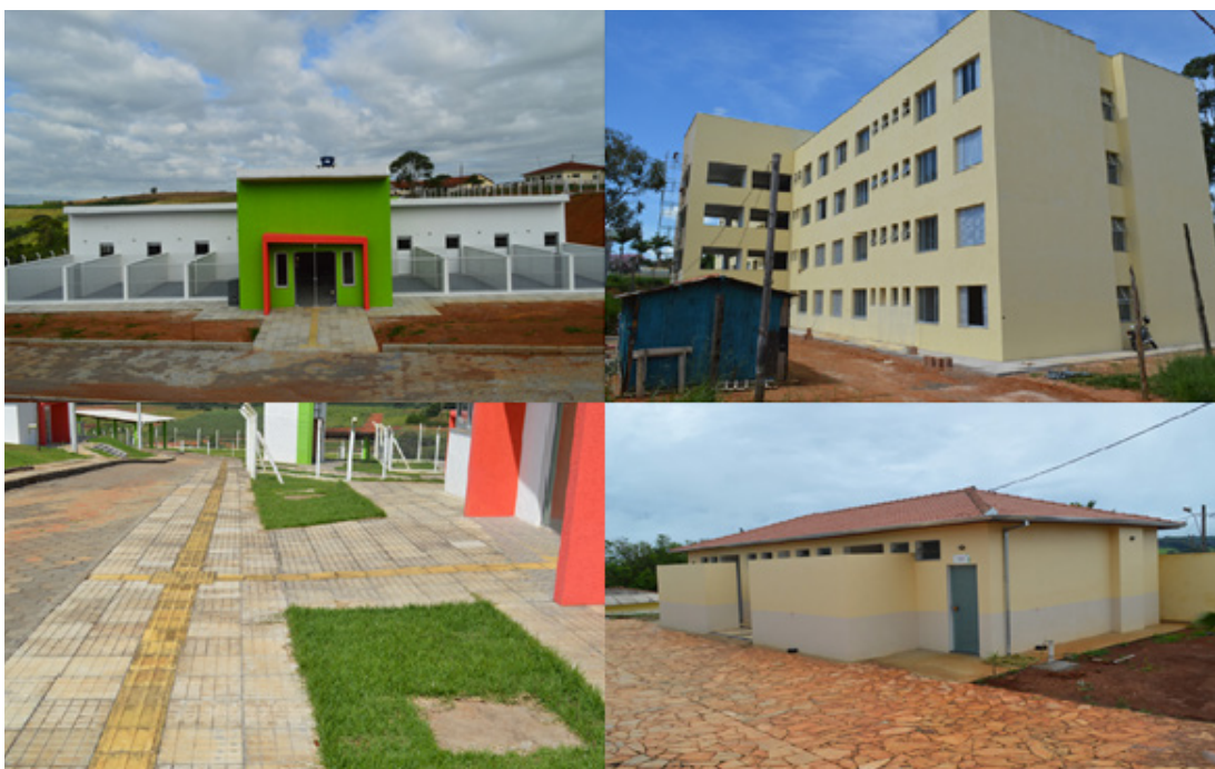
Figura 39 – Algumas das obras no Campus Muzambinho 26
