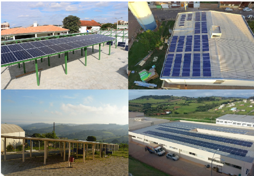
Figura 73 – Placas fotovoltaicas instaladas nas unidades do IFSULDEMINAS
