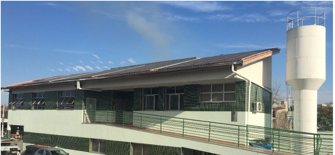
Figura 57 – Vista do prédio da DTI 28
