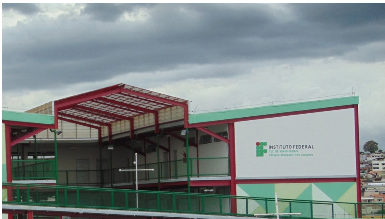
Figura 08 – Fachada do Campus Avançado Três Corações
