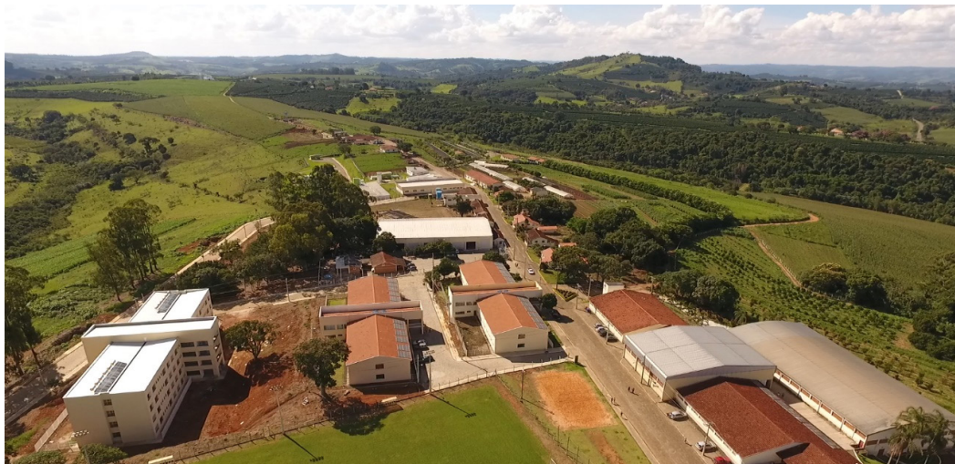
Figura 40 – Vista aérea do Campus Muzambinho
