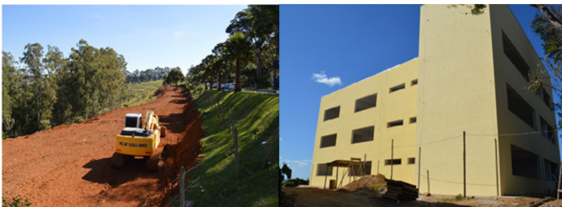
Figura 38 – Obras do Prédio Pedagógico do curso de Medicina Veterinária
