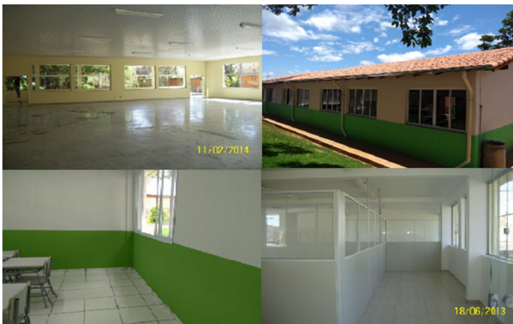
Figura 42 – Obras no Campus Passos
