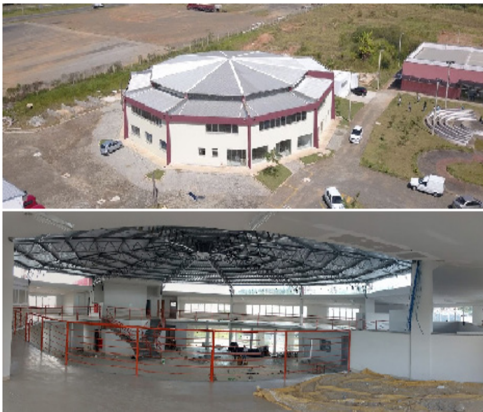
Figura 45 – Obras da nova biblioteca do Campus Poços de Caldas
