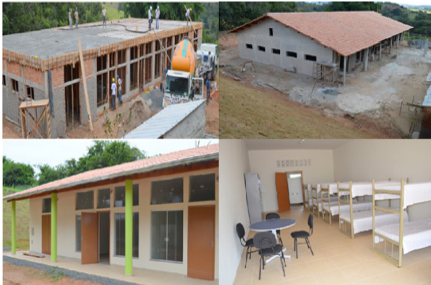
Figura 35 – Novo Alojamento feminino: etapas da construção
