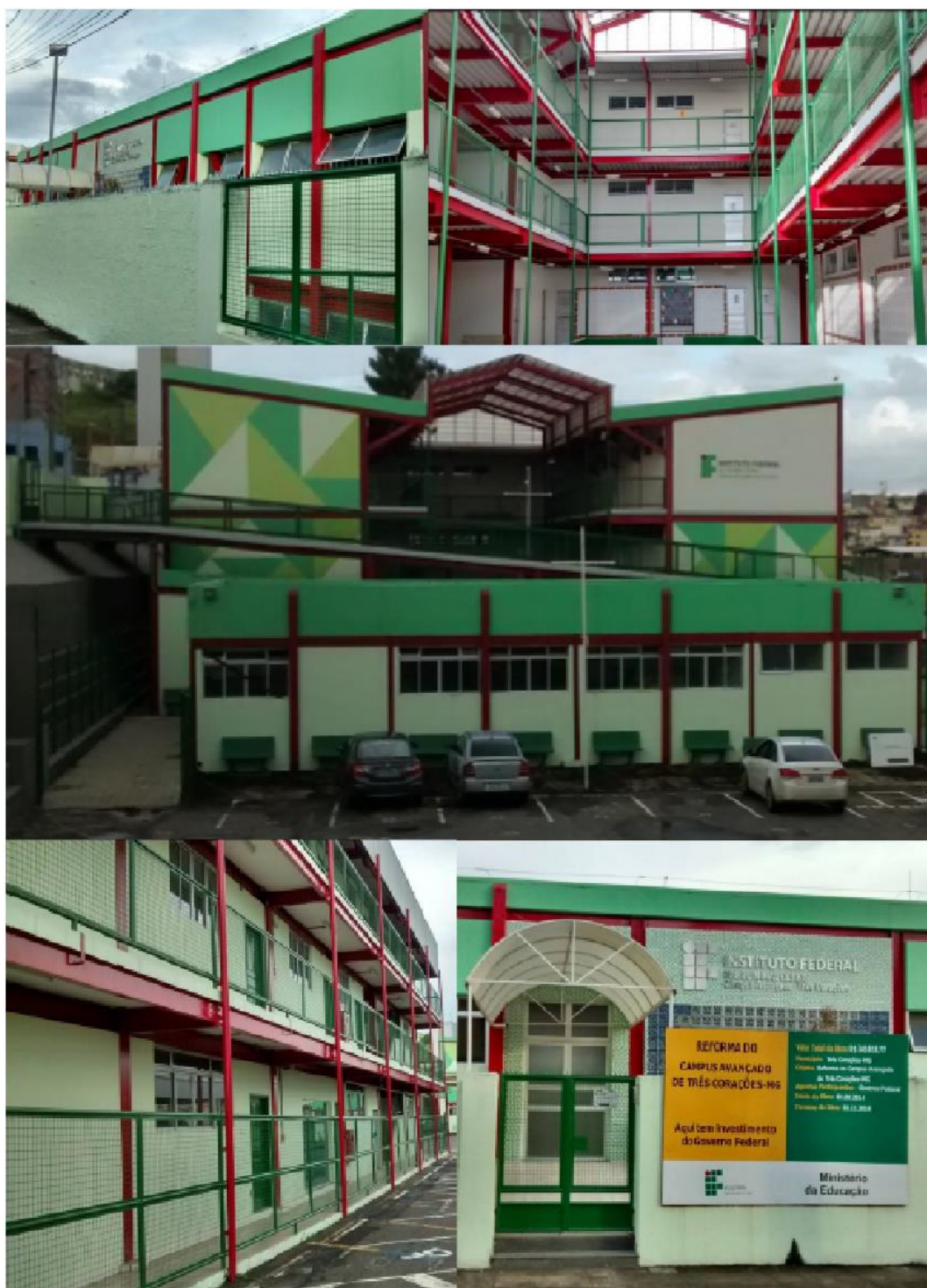
Figura 7 - Blocos pedagógicos e administrativos (Unidade I).
