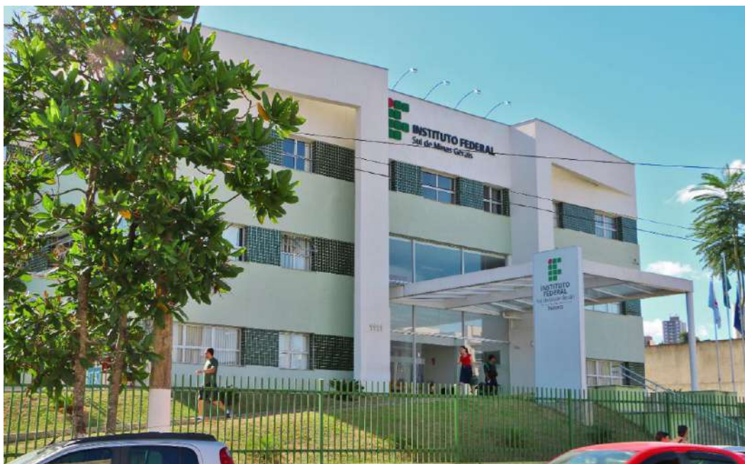
Figura 18 - Fachada do prédio principal da Reitoria do IFSULDEMINAS
