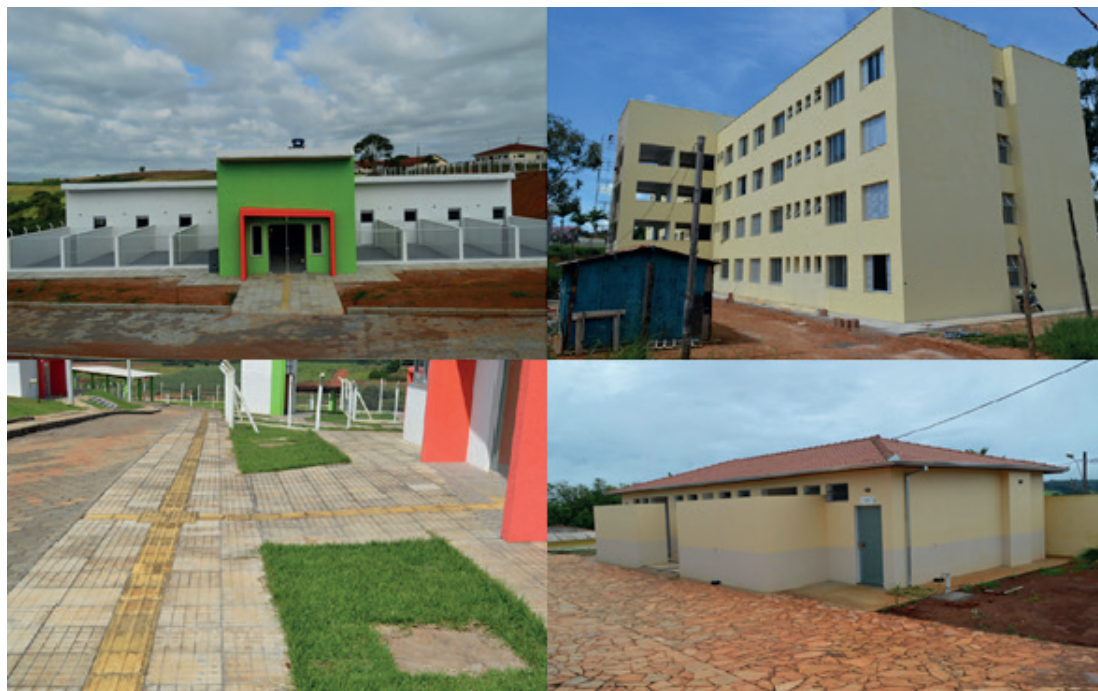
Figura 39 – Algumas das obras no Campus Muzambinho 26
