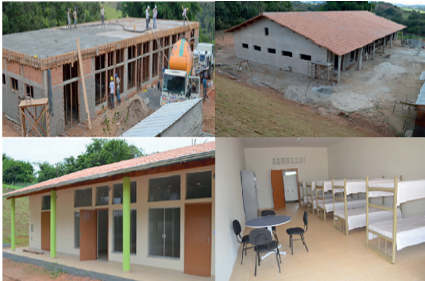
Figura 35 – Novo Alojamento feminino: etapas da construção
