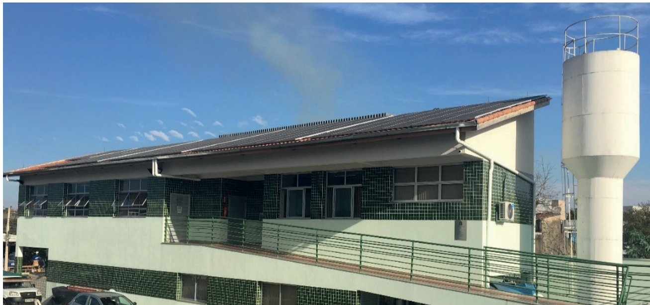
Figura 57 – Vista do prédio da DTI 28
