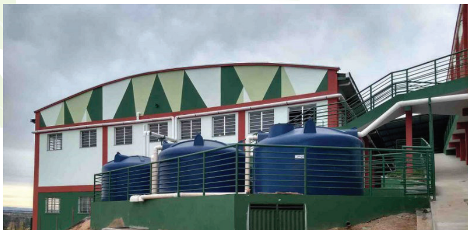
Figura 5: Instalação de reservatórios para uso/reuso de água pluvial em uma das unidades do IFSULDEMINAS.
