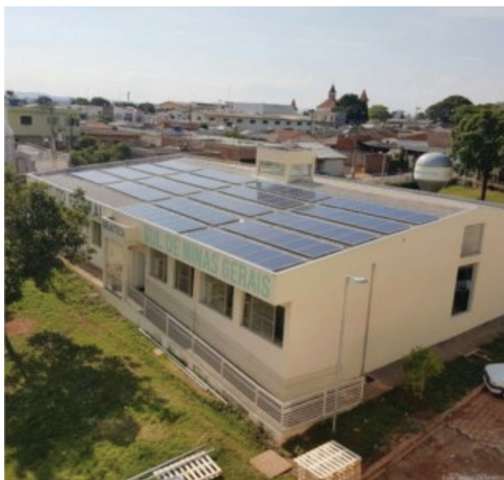
Figura 3: Instalação de usina solar em uma das unidades do IFSULDEMINAS.
