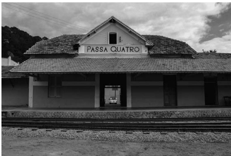
Figura 5 – Prédio da Estação Ferroviária de Passa Quatro
