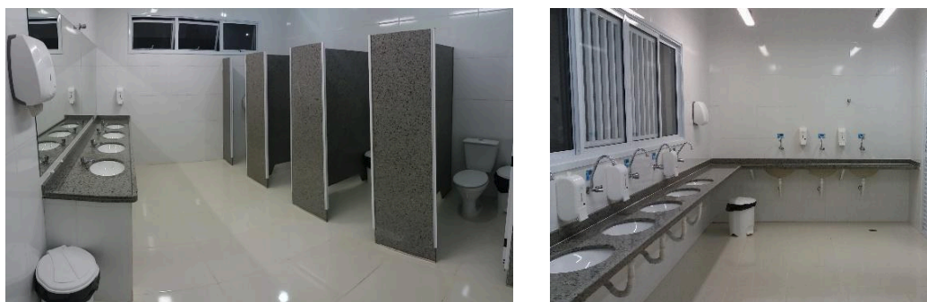
Figura 17 - Sanitários e Barreira Sanitária
