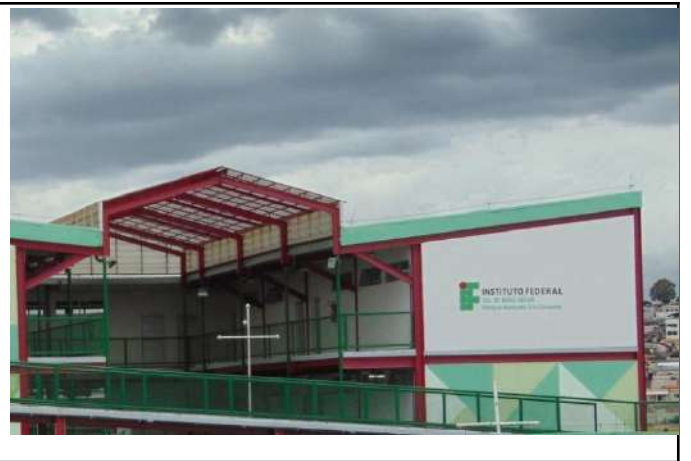
Figure 8: Campus Três Corações natural ventilation and lighting.
