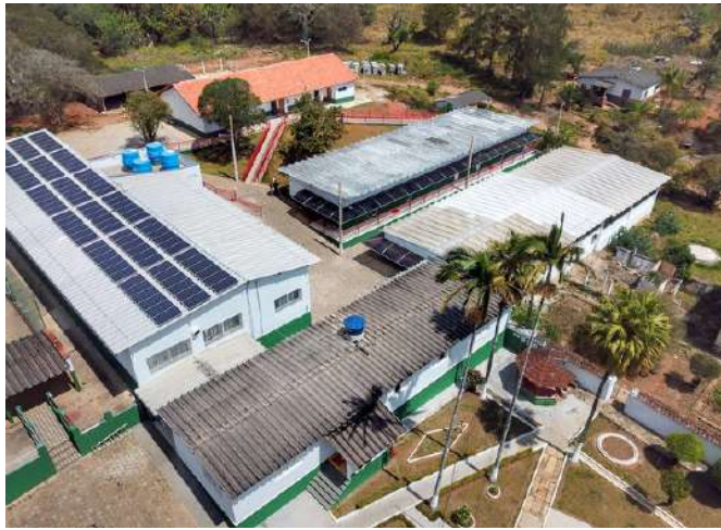
Figure 7: Campus Carmo de Minas Alameda Murilo Eugênio Rubião, s/nº - Bairro Chacrinha - CEP 37.472-000 - Carmo de Minas - MG
